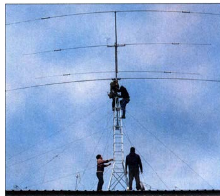
Antennenarbeiten an der Klubstation
