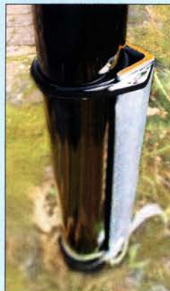
Bild 5: Fixierung des Mastes an einem Stahlprofil; um Beschädigungen des Mastes zu verhindern, sind an den Klemmstellen Gummibänder unterzulegen.
